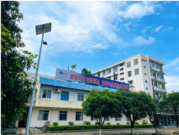
主干道安装太阳能灯
