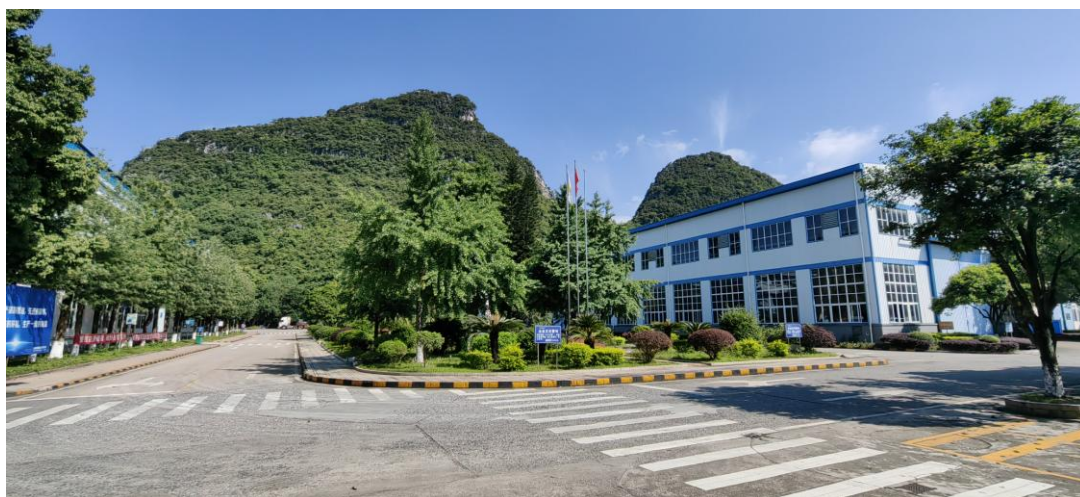
厂区环境持续改善
